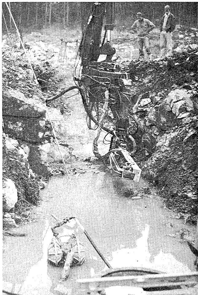
Fig 3 Borrustrustningen klarar även borring av kanthål i botten av rörgrav
